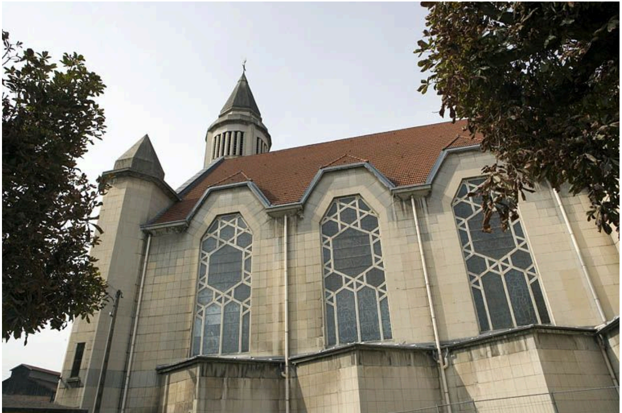
Vue extérieure de la nef.
