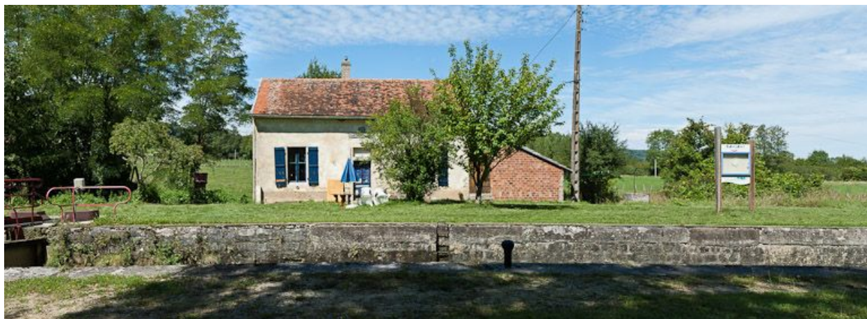
Vue de face de la maison éclusière.
