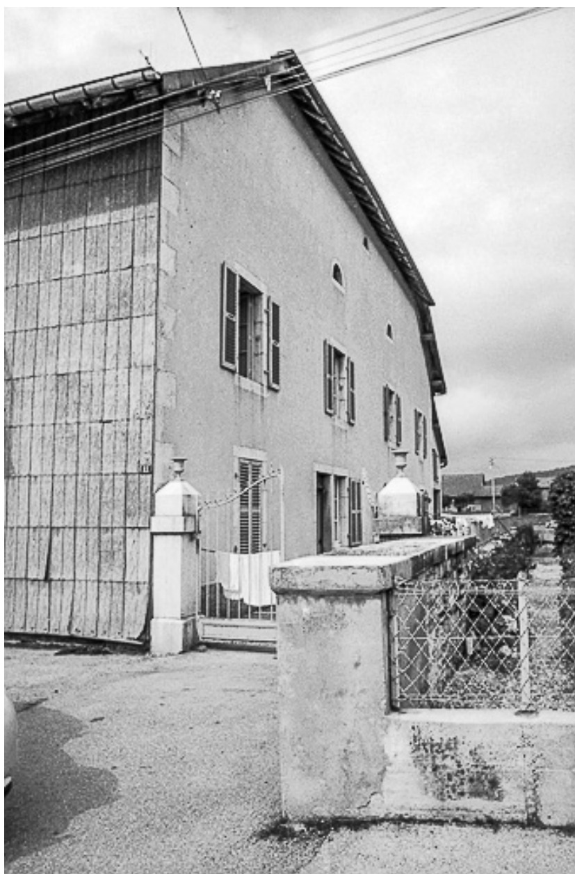
Ferme cadastrée 1962 E 281 bis : façade antérieure.
