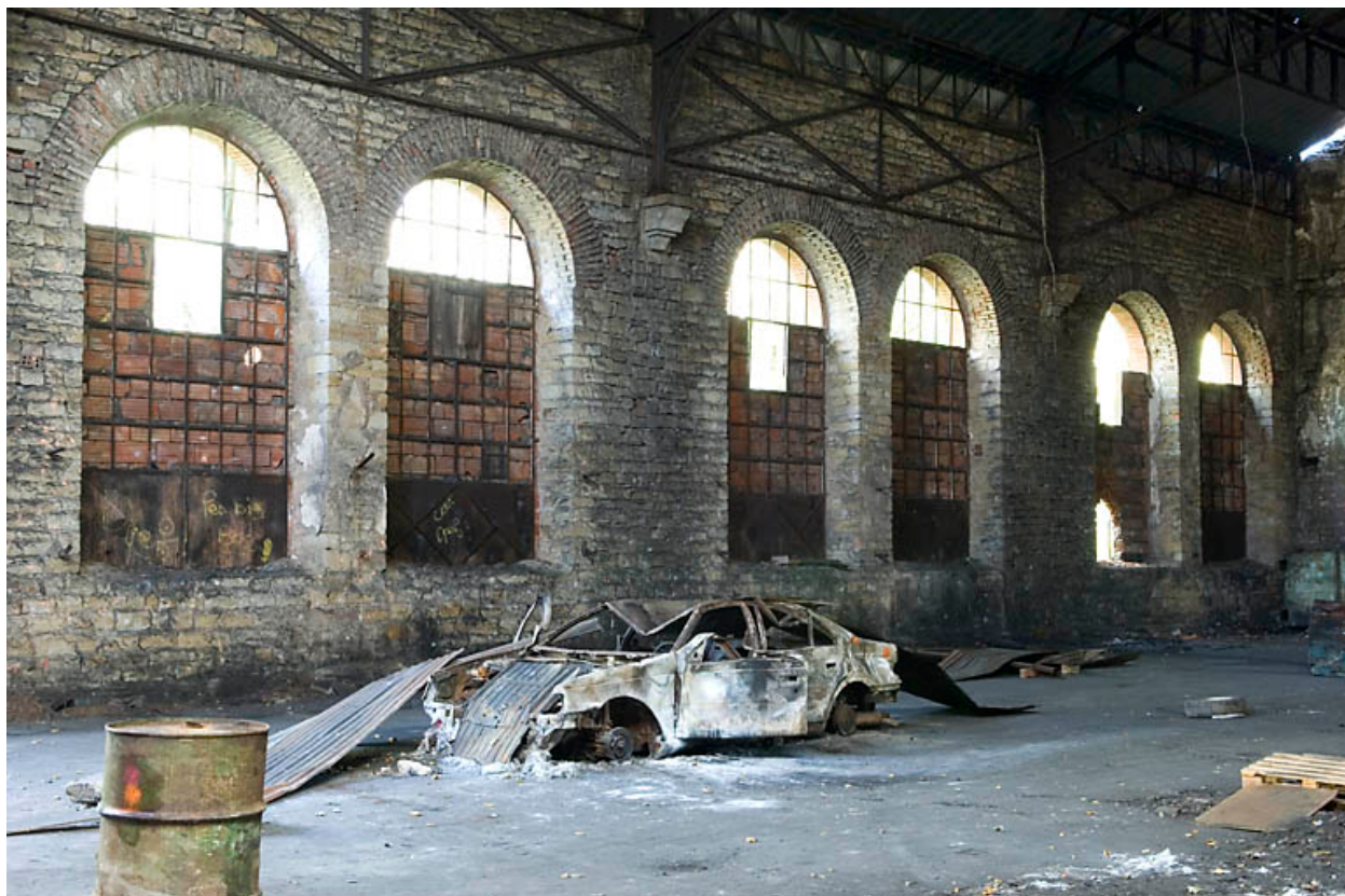
Mur nord du bâtiment des vestiaires.
