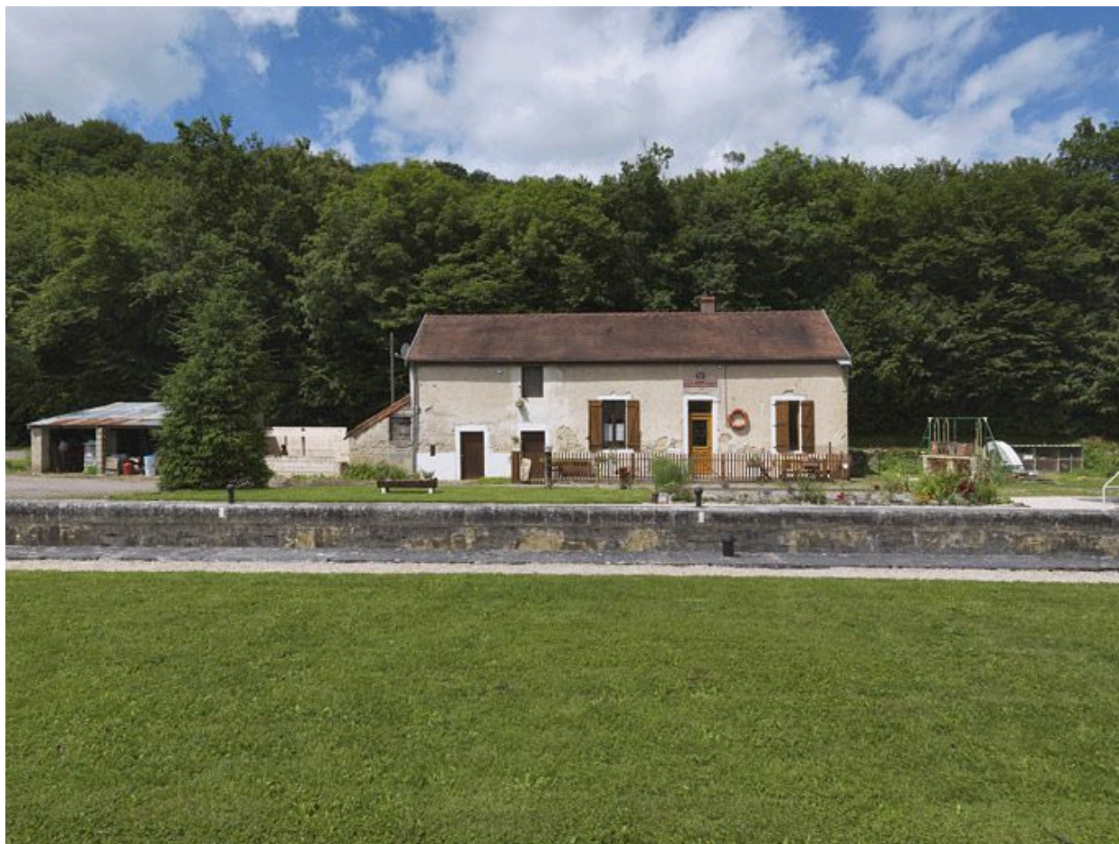
Maison éclusière vue de face.
