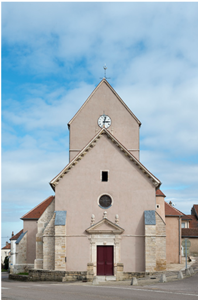
La façade occidentale.
