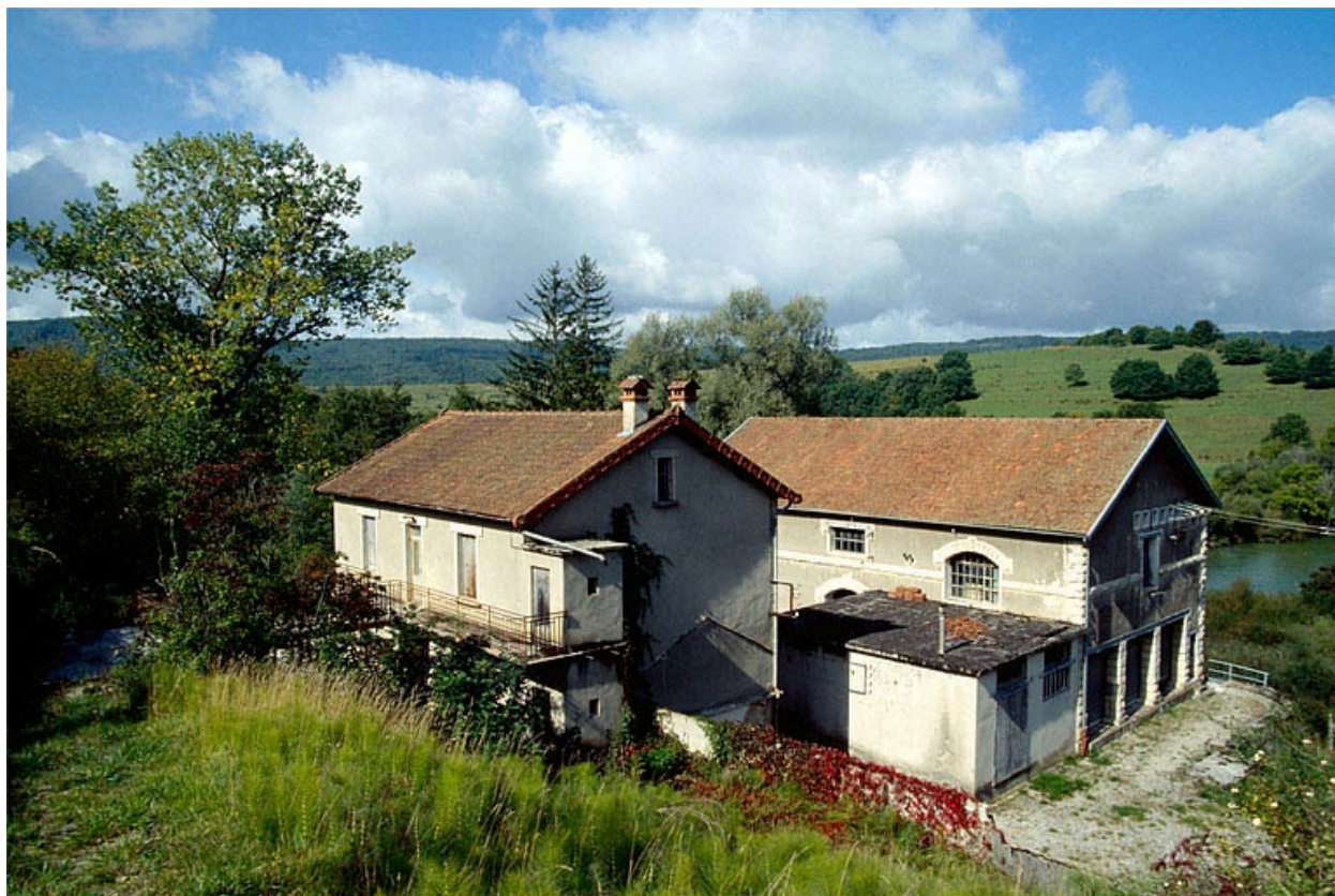
Centrale hydroélectrique de Chalain, Marigny.
