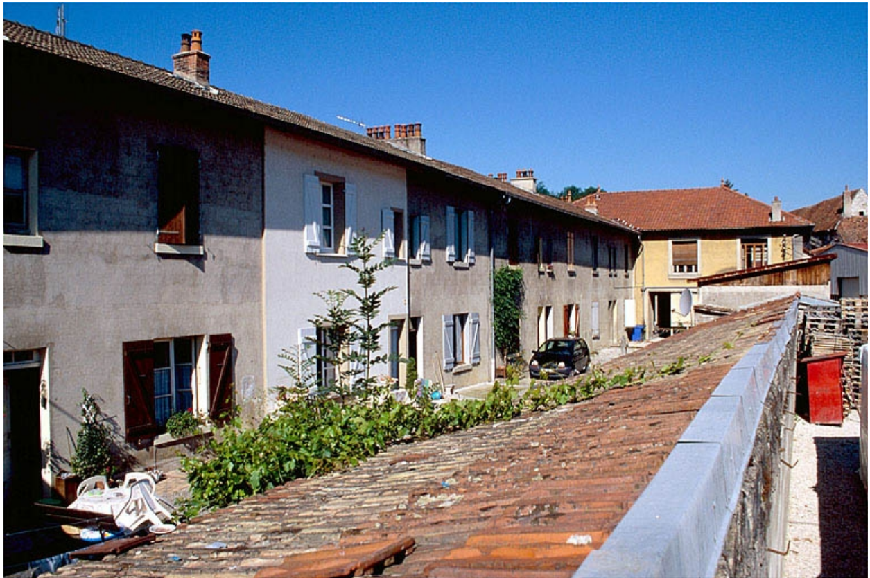
Façade postérieure des logements ouvriers.
