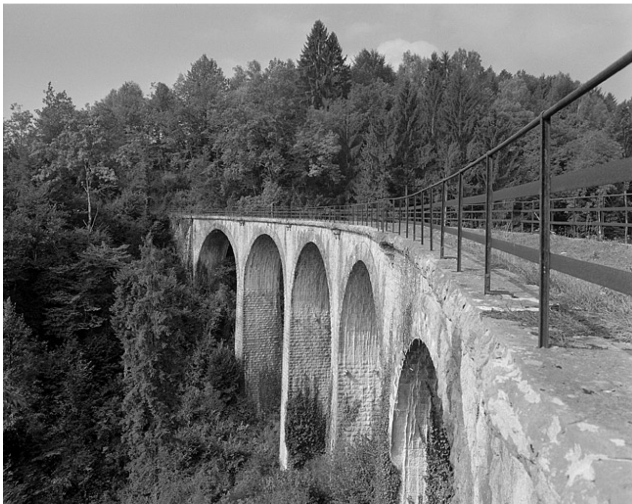
Les cinq arches du viaduc.
