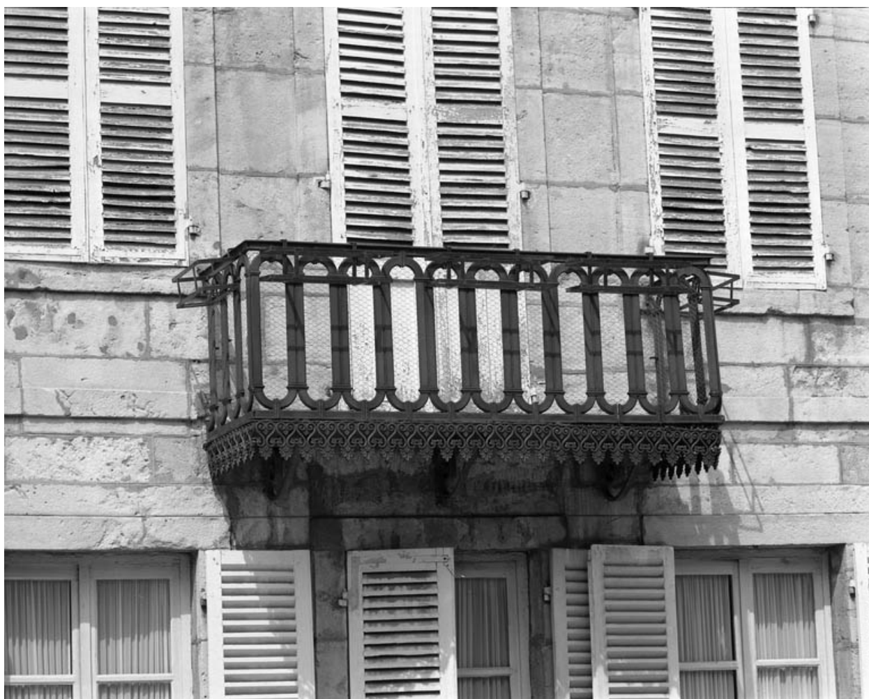
Façade antérieure : détail du balcon en ferronnerie.
