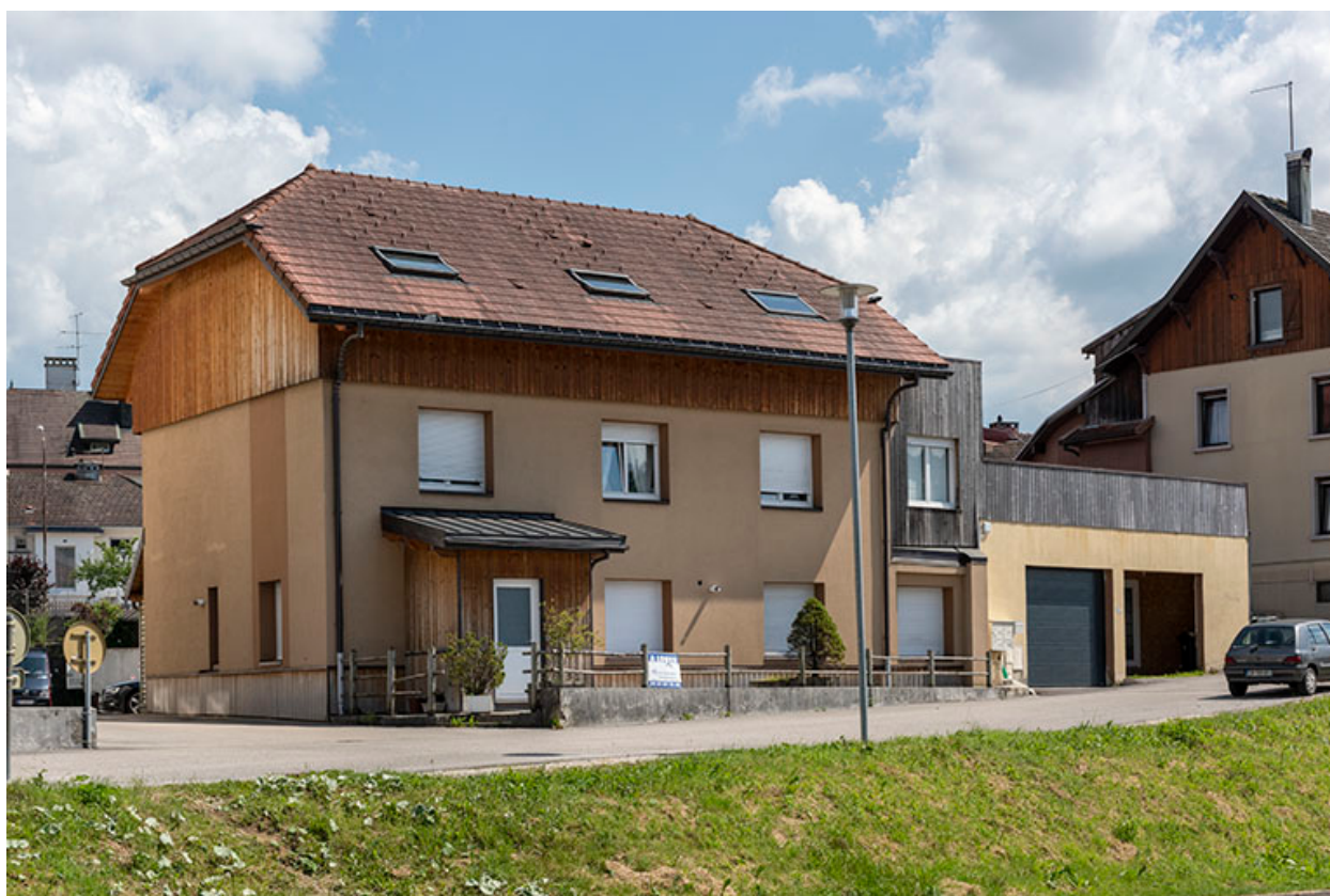
Ancien pavillon (à droite).
