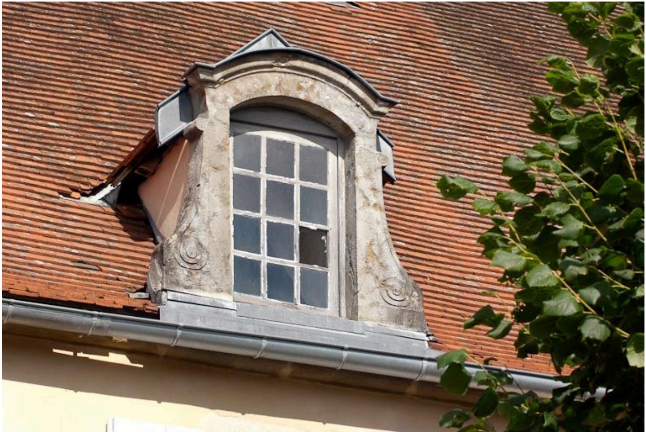
Lucarne de la façade antérieure.
