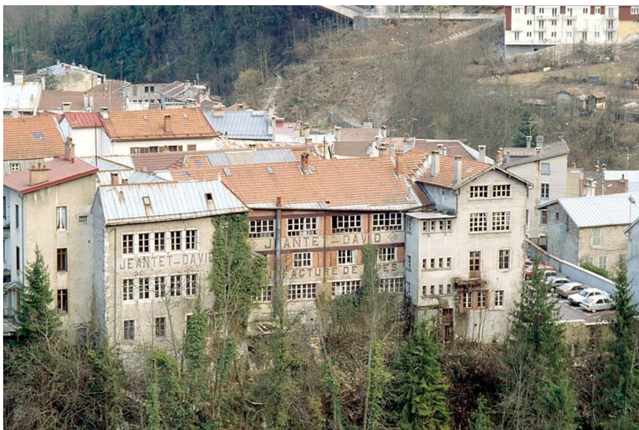
Vue d'ensemble rapprochée depuis l'ouest.
