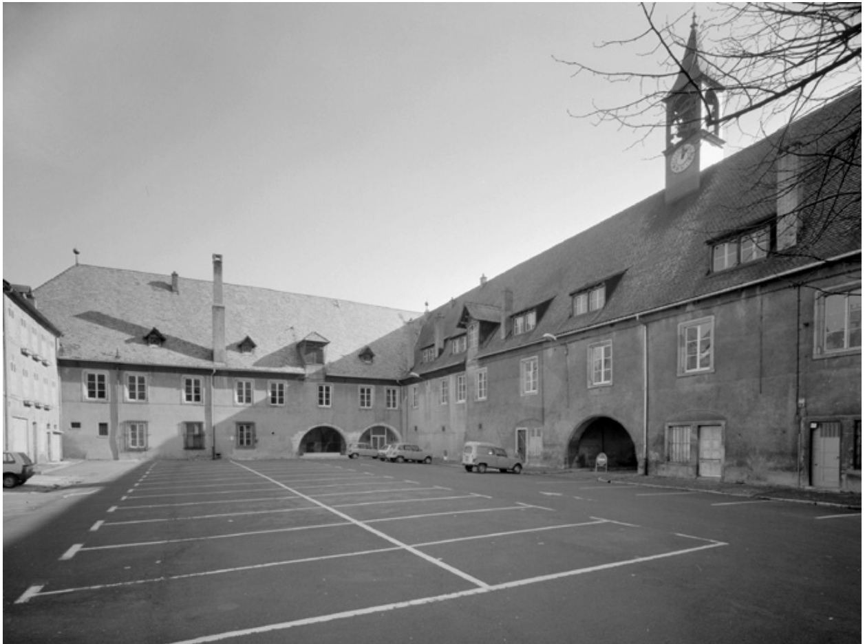
Cour [corps de bâtiment principal à droite et aile est au fond].
