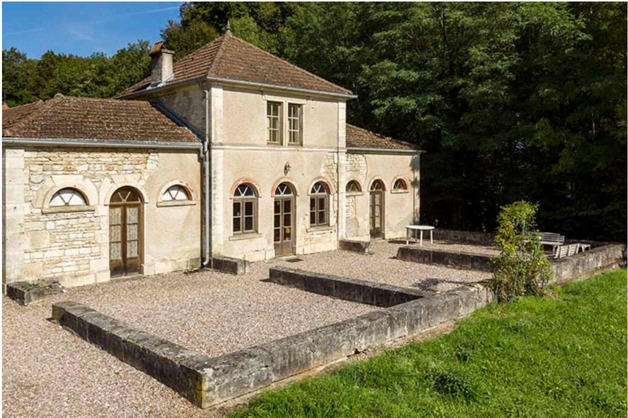
La façade antérieure, exposée au sud-est.
