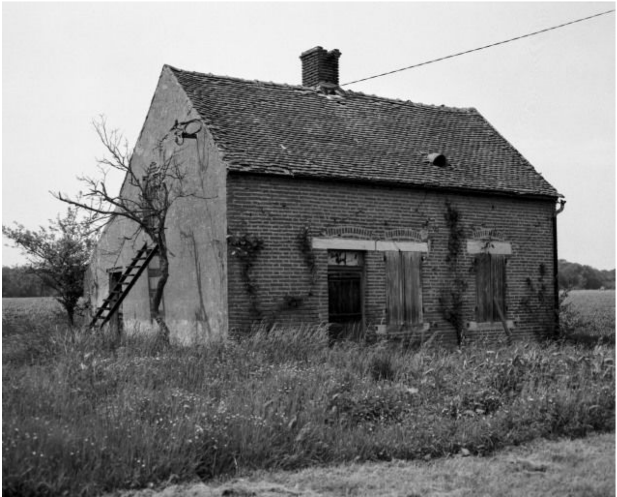
Logis d'une ferme (cad. 1934, sect. A2, parc. 124).
