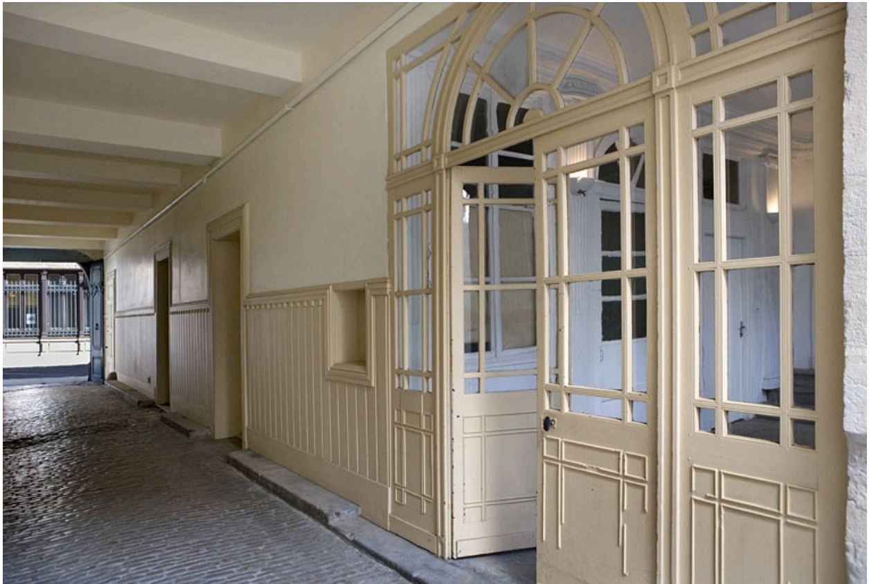
Entrée du vestibule depuis le passage cocher.
