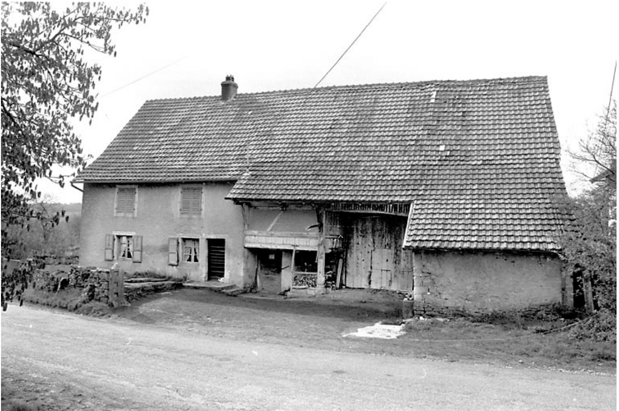
8e ferme : vue d'ensemble.
