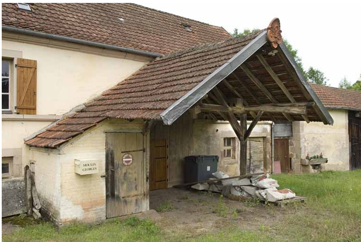
Auvent sur la façade antérieure.
