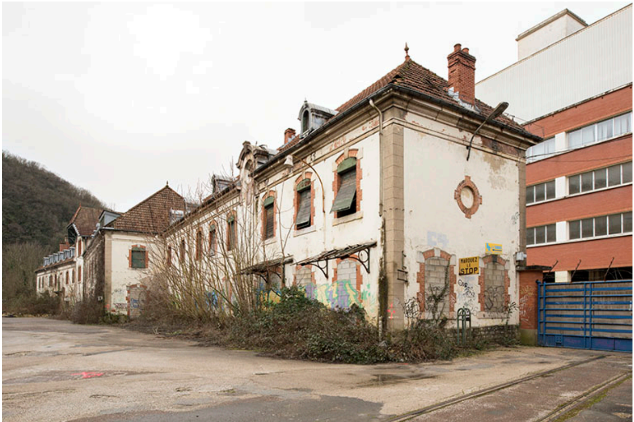
Etat en 2016. Usine A : façade sur cour des bureaux, depuis l'est.
