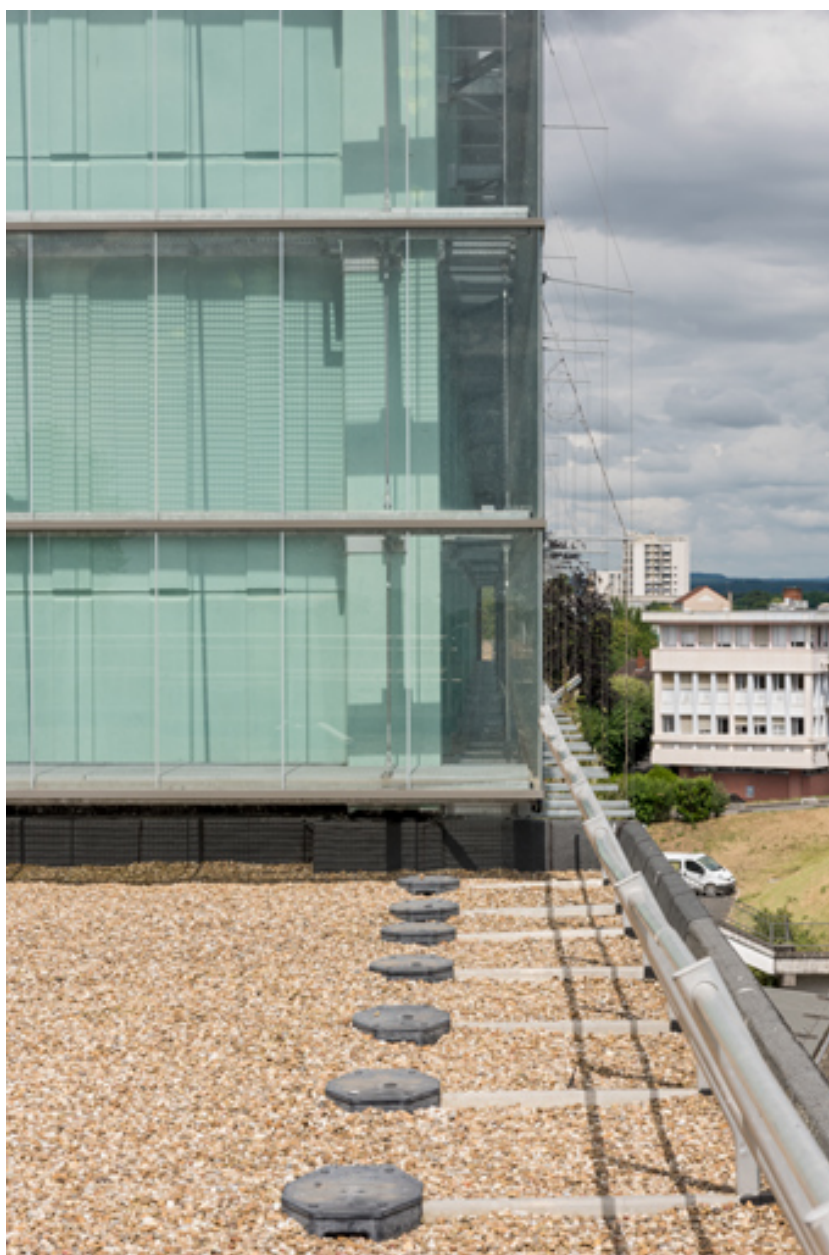
Maison de la culture : détail de la cage de scène et du mur pariéto-dynamique, depuis le toit.
