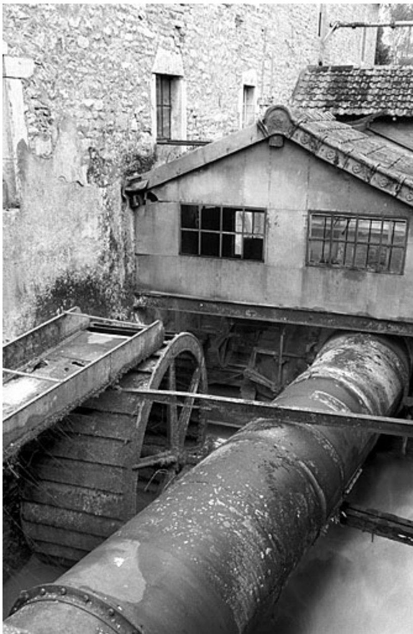
Roue hydraulique, conduite forcée et bâtiment d'eau.
