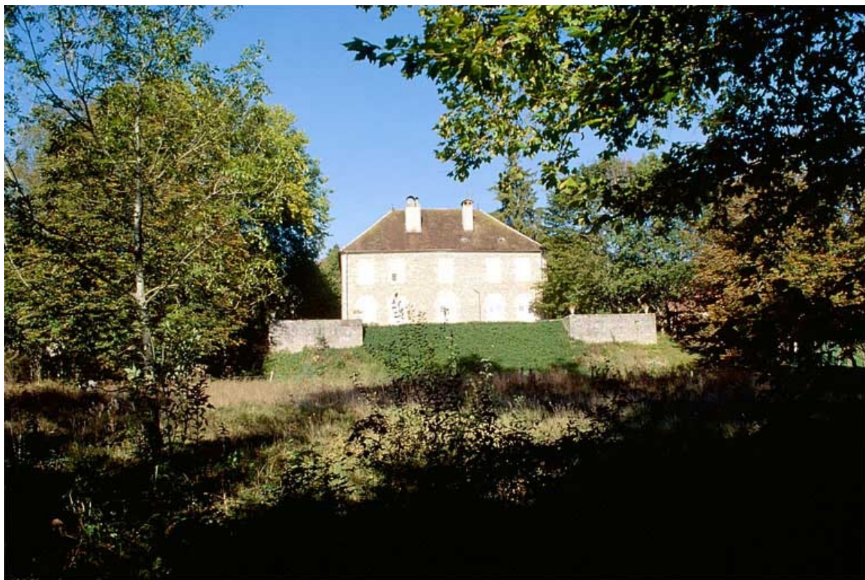
Façade postérieure du logement patronal.
