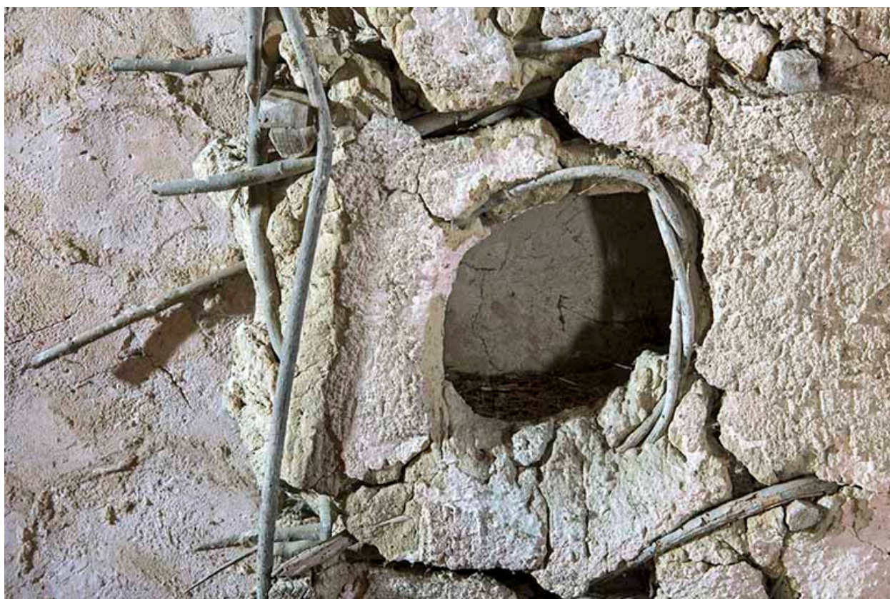
Détail d'un boulin.
