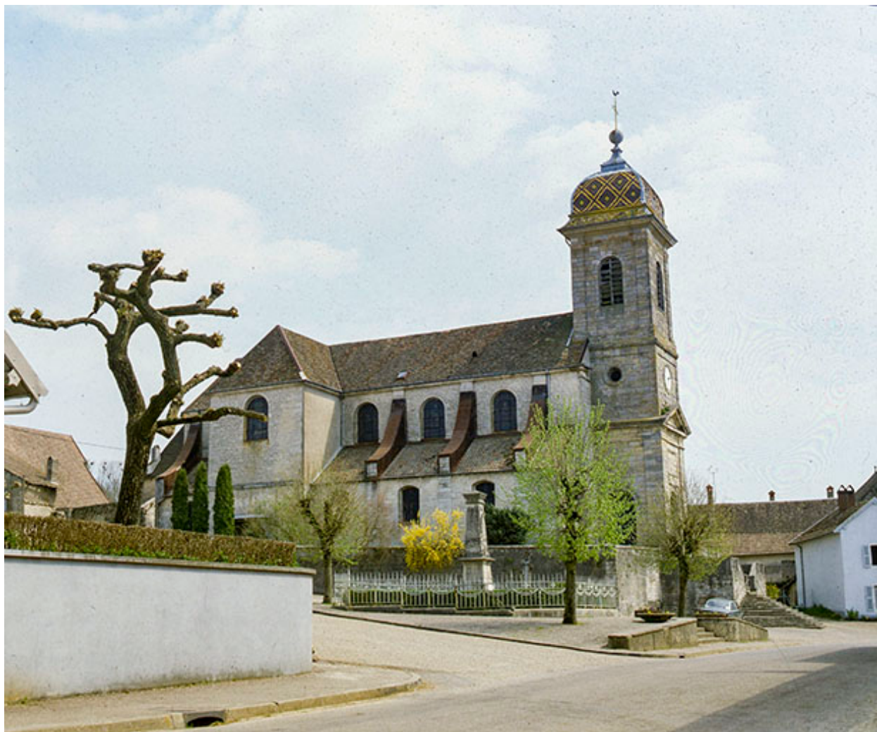
Façade laérale gauche.
