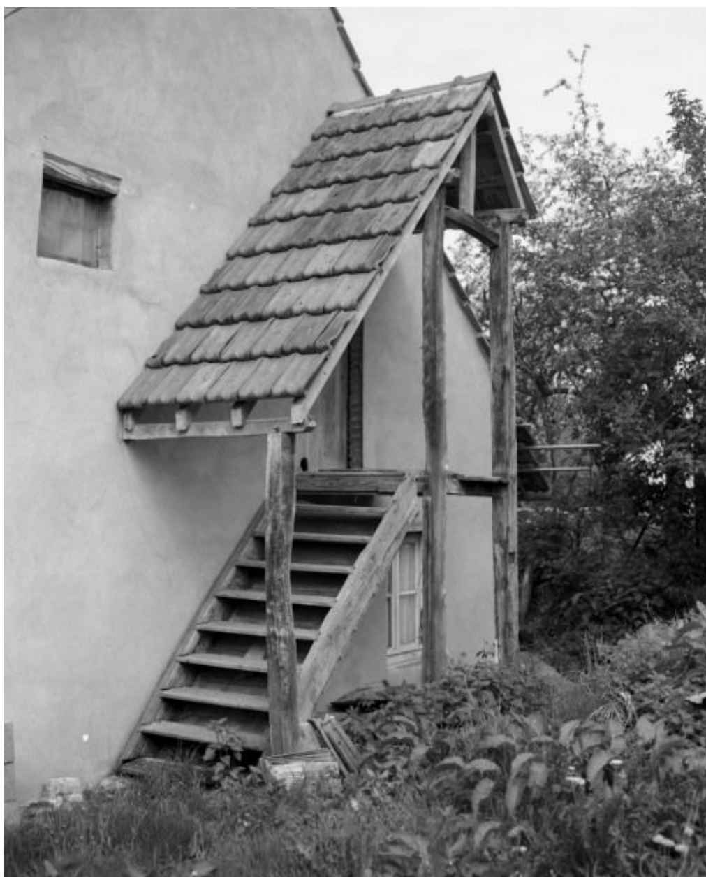
Escalier d'accès au comble.
