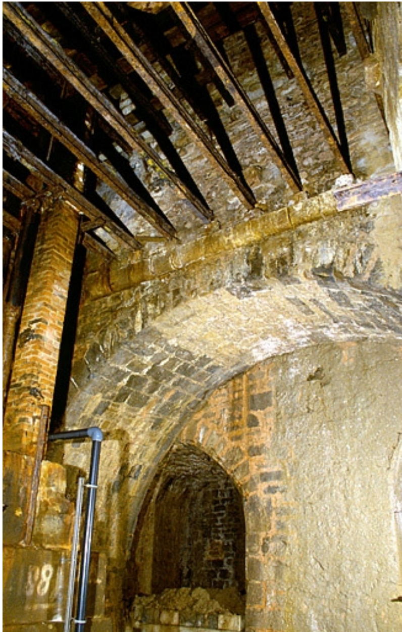
Angle nord-ouest du puits à Muire en contre-plongée.
