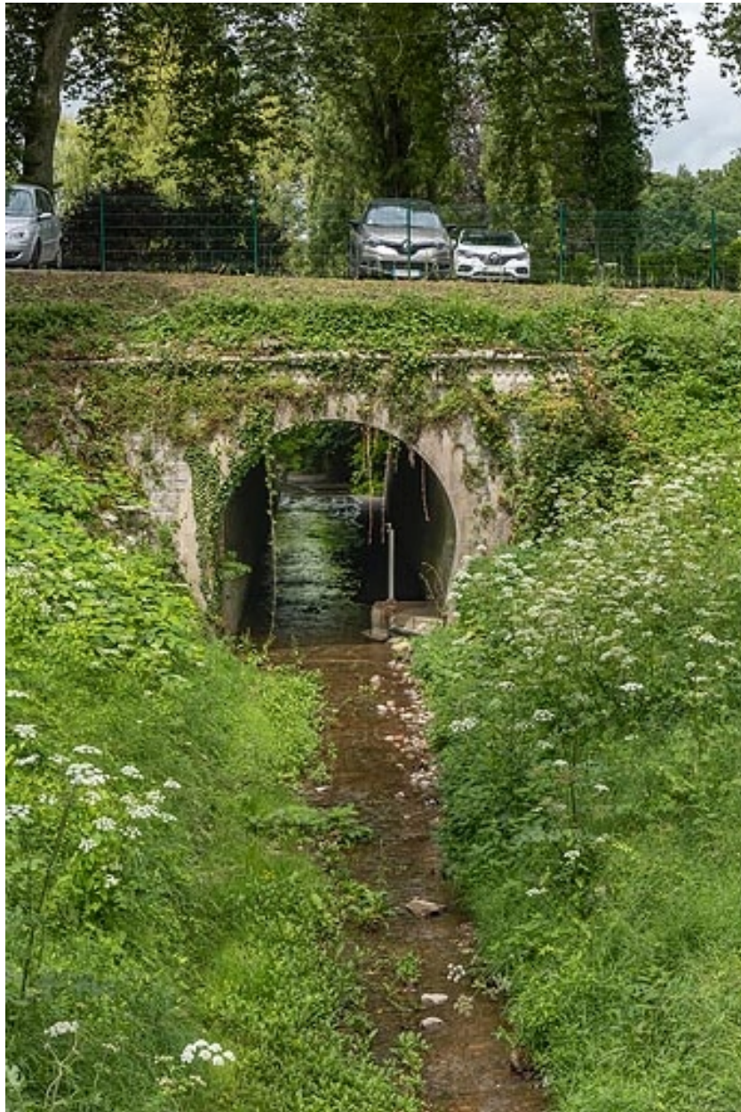
Tunnel du Borne sous l'allée d'Aligre.
