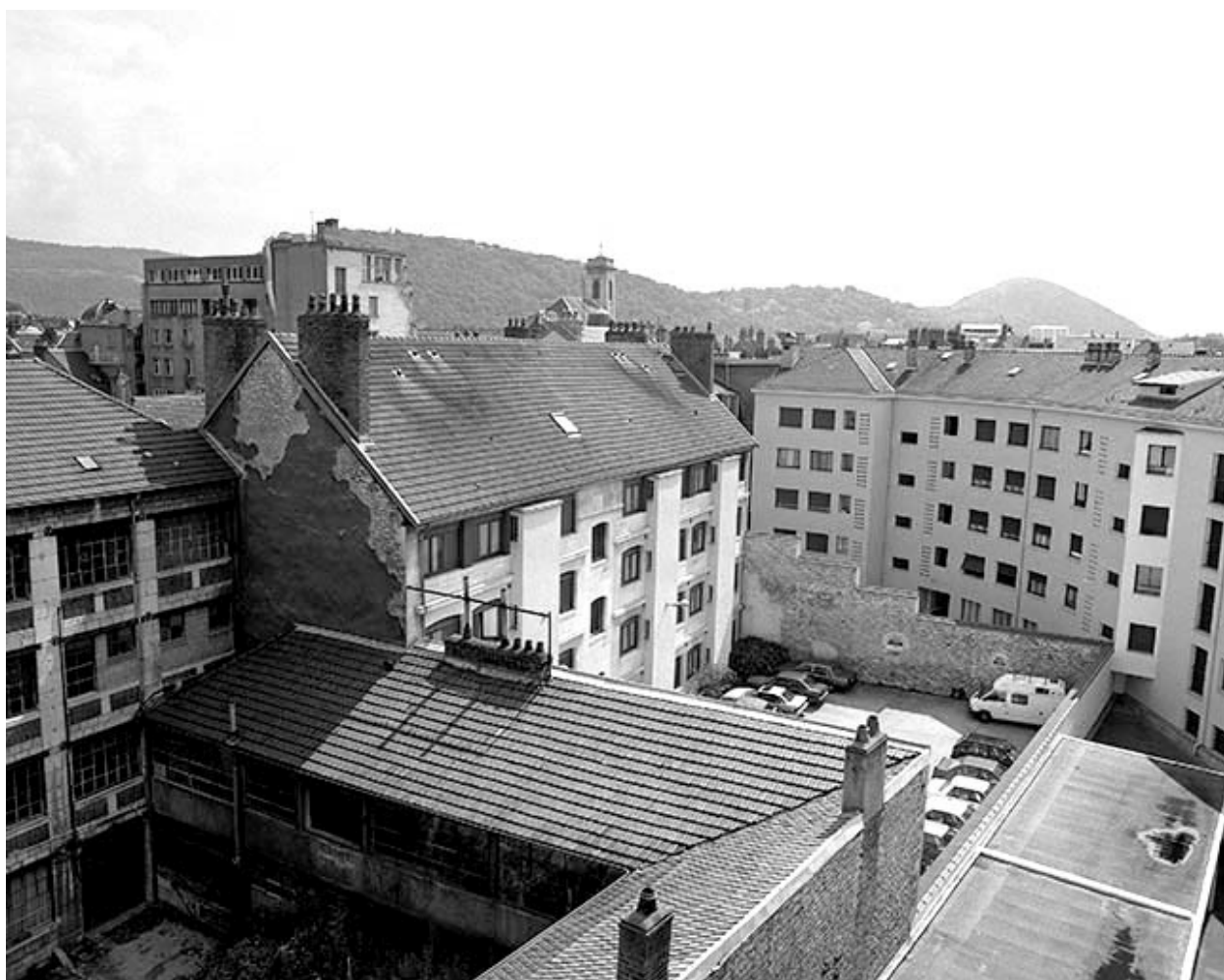
Vue plongeante depuis le nord-est en 1996.
