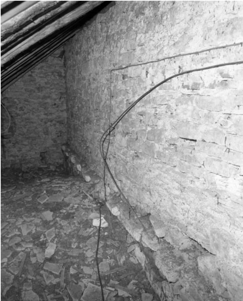
Comble de la chapelle Saint-Joseph : corniche à modillons du mur gauche du chœur.
