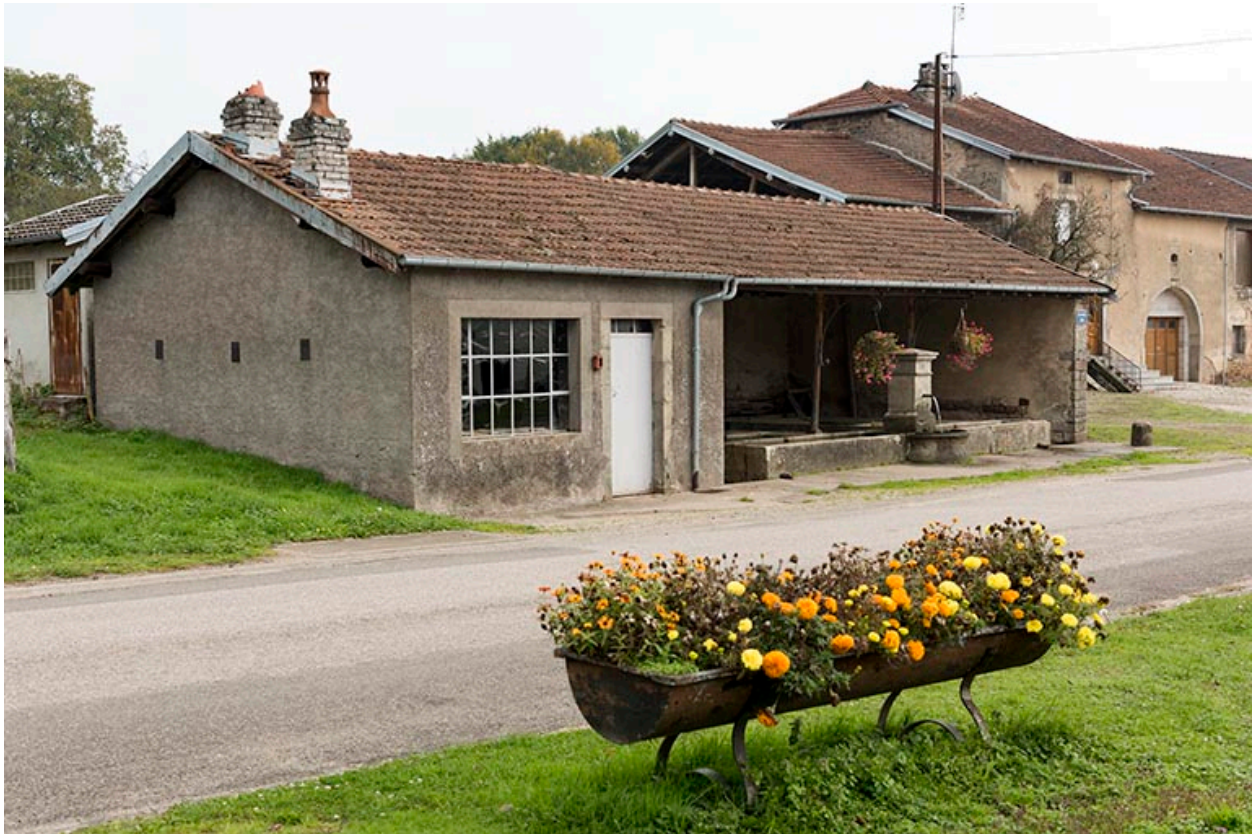
Fontaine-lavoir de la Grande rue.
