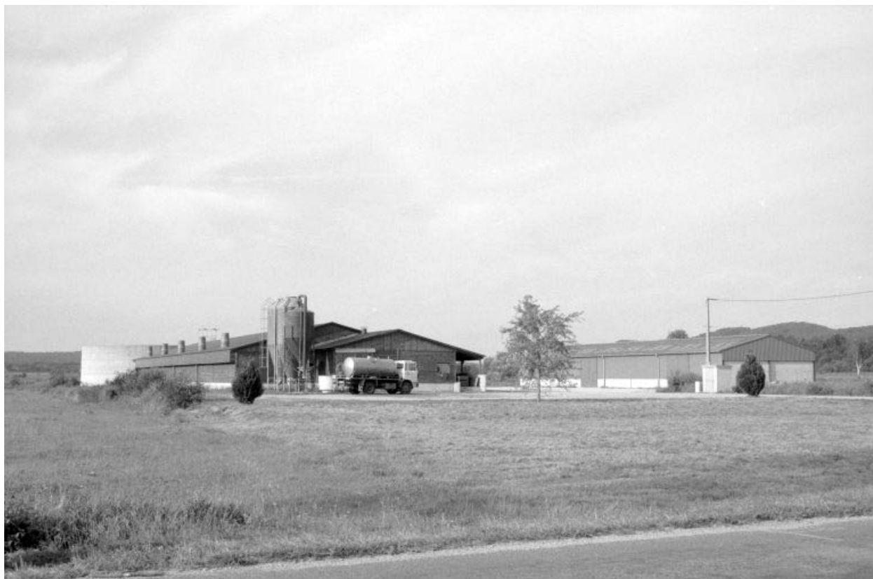
Porcherie et cave d'affinage vues du sud-ouest.
