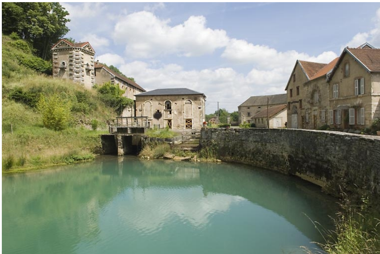
Source de la Baignotte et salle des machines.
