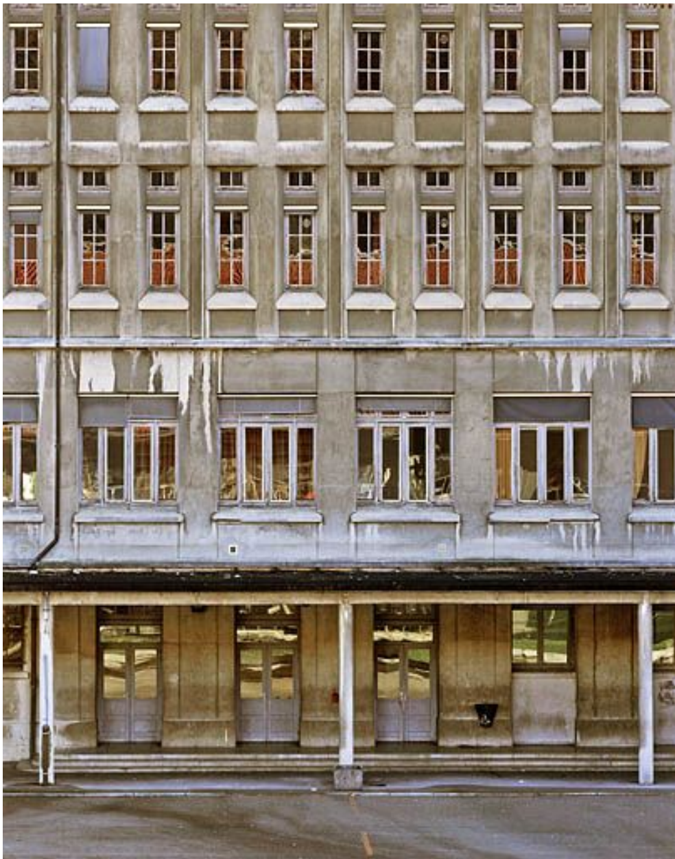
Bâtiment D : détail de la façade sur la cour, avant restauration.
