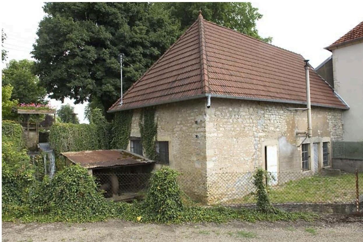
Local de la turbine et atelier.
