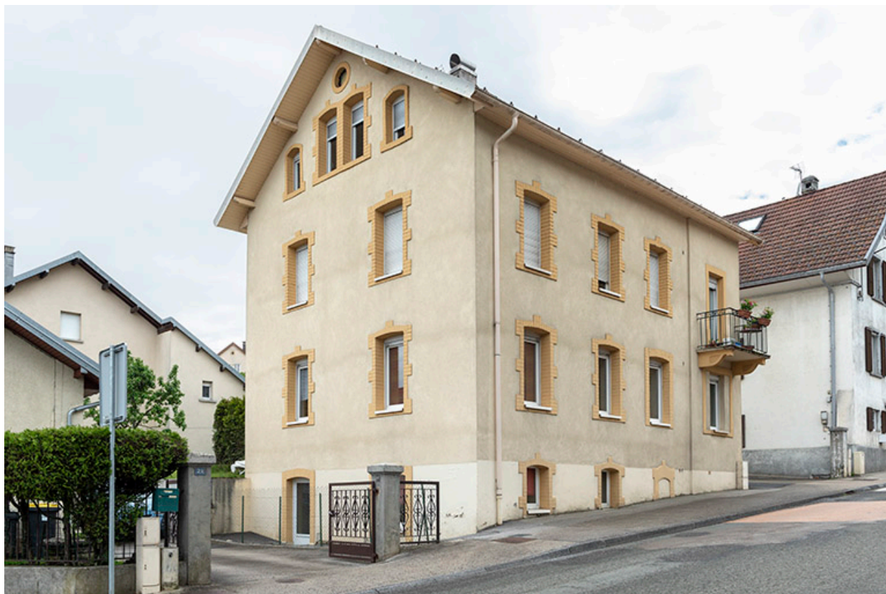
Façades antérieure et latérale gauche.
