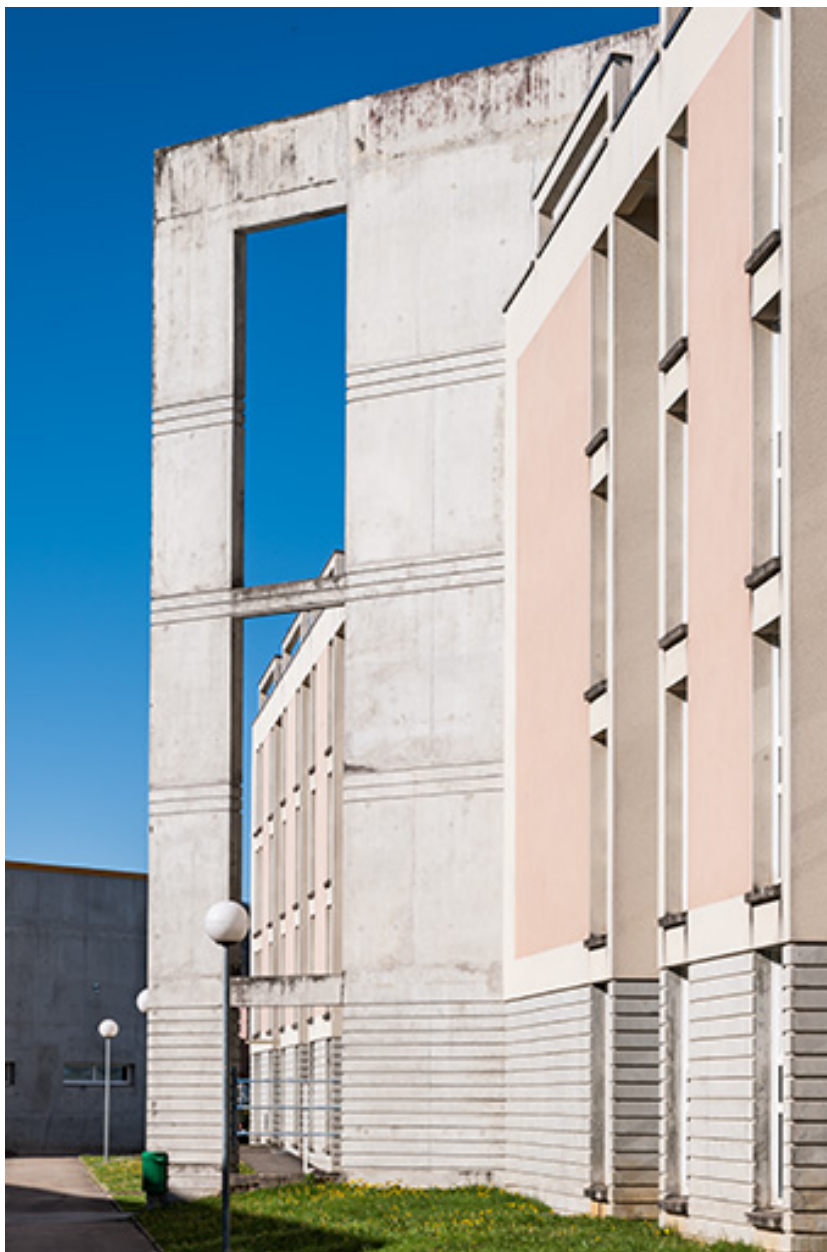
Internat : façade antérieure.
