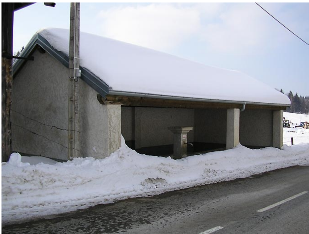
Vue générale trois quarts.
