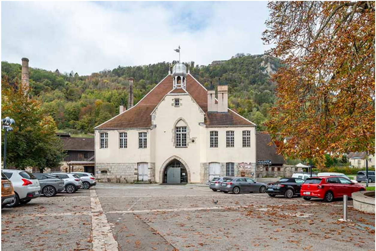
Maison du Pardessus. Vue depuis l'est.
