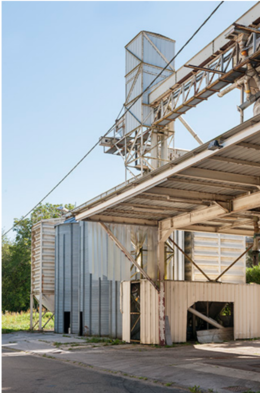
Installations de chargement/déchargement.
