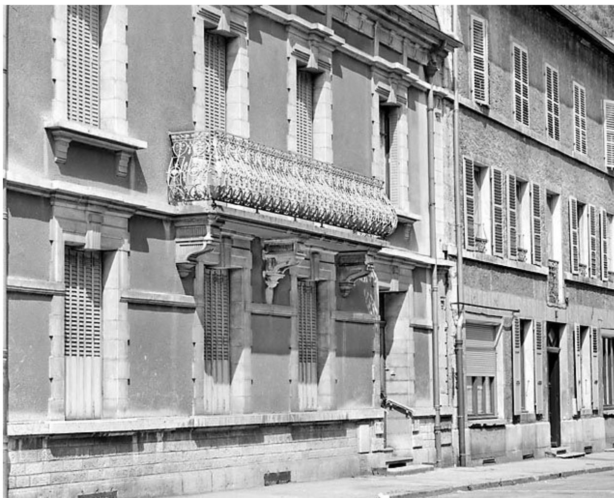
Elévation antérieure : baies.
