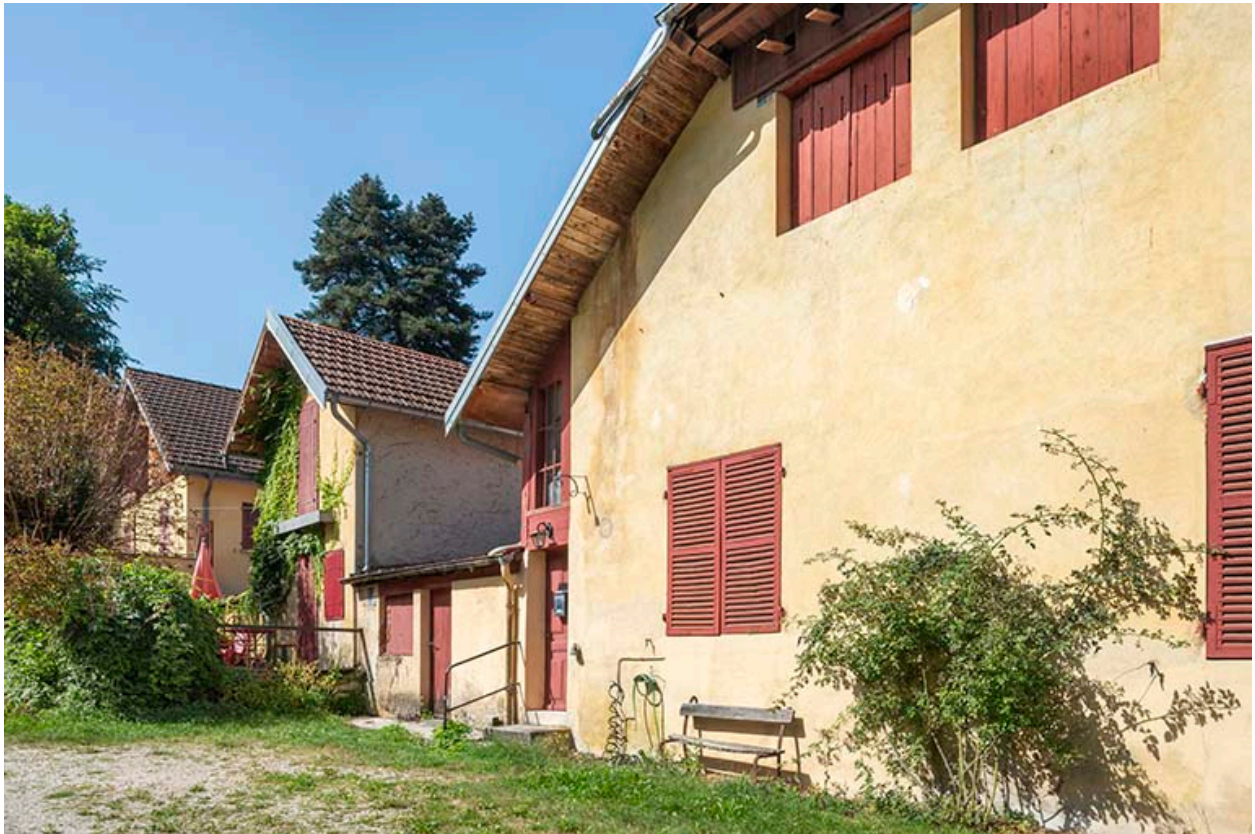
Façades et pignons est.
