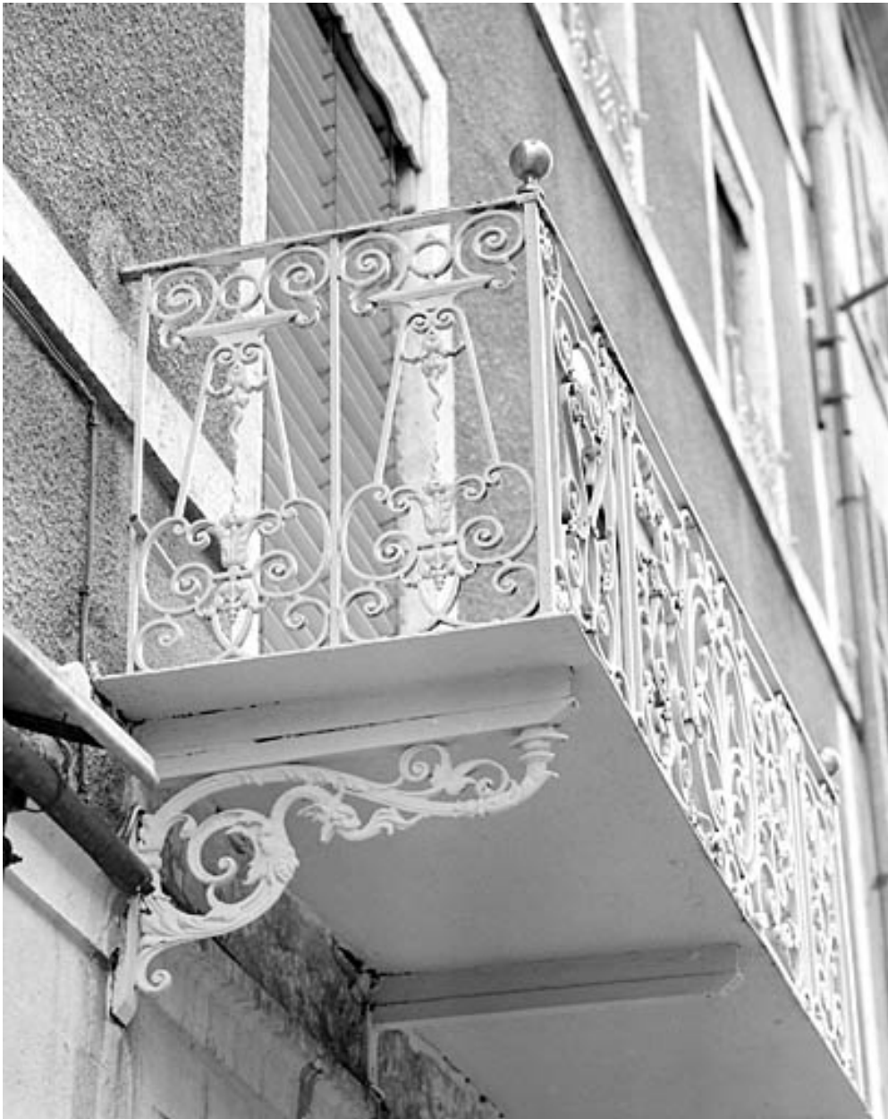
Balcon du premier étage : garde-corps et console.
