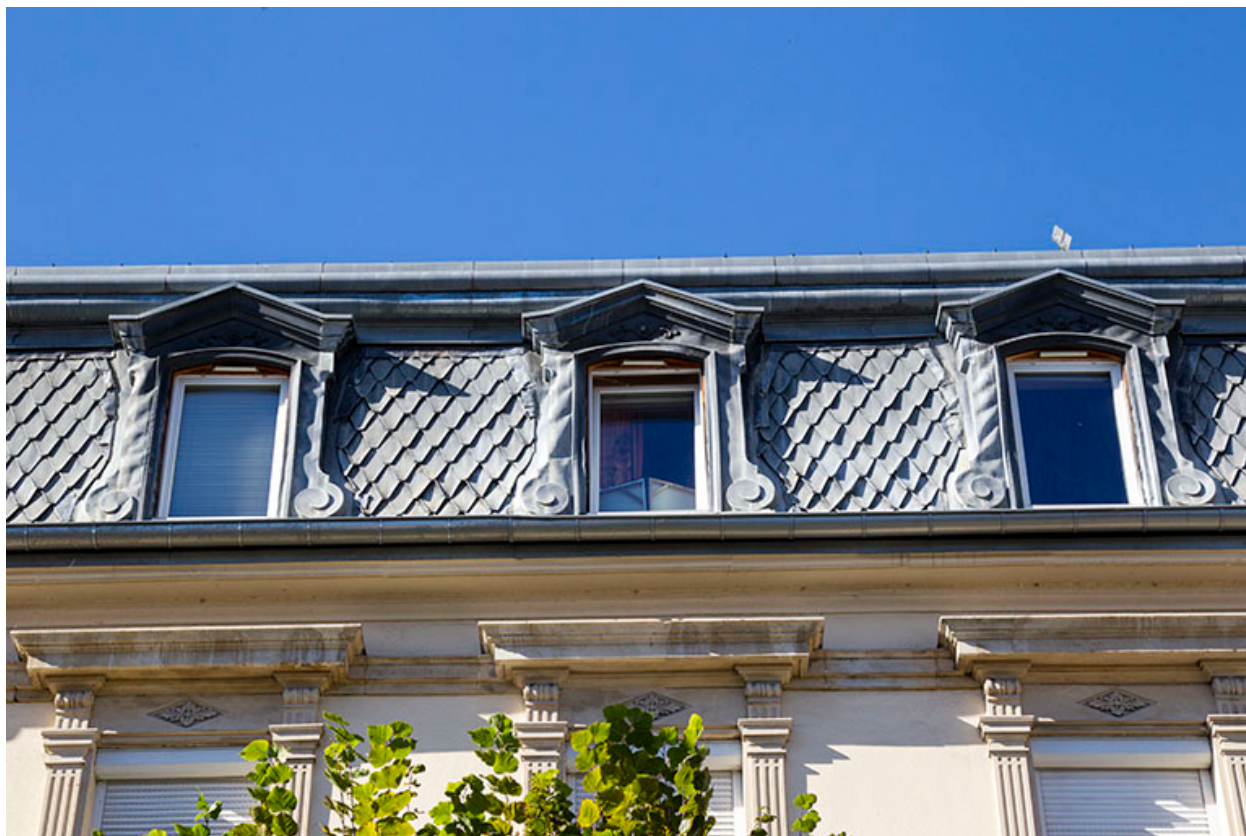
Façade antérieure : baies du brisis.
