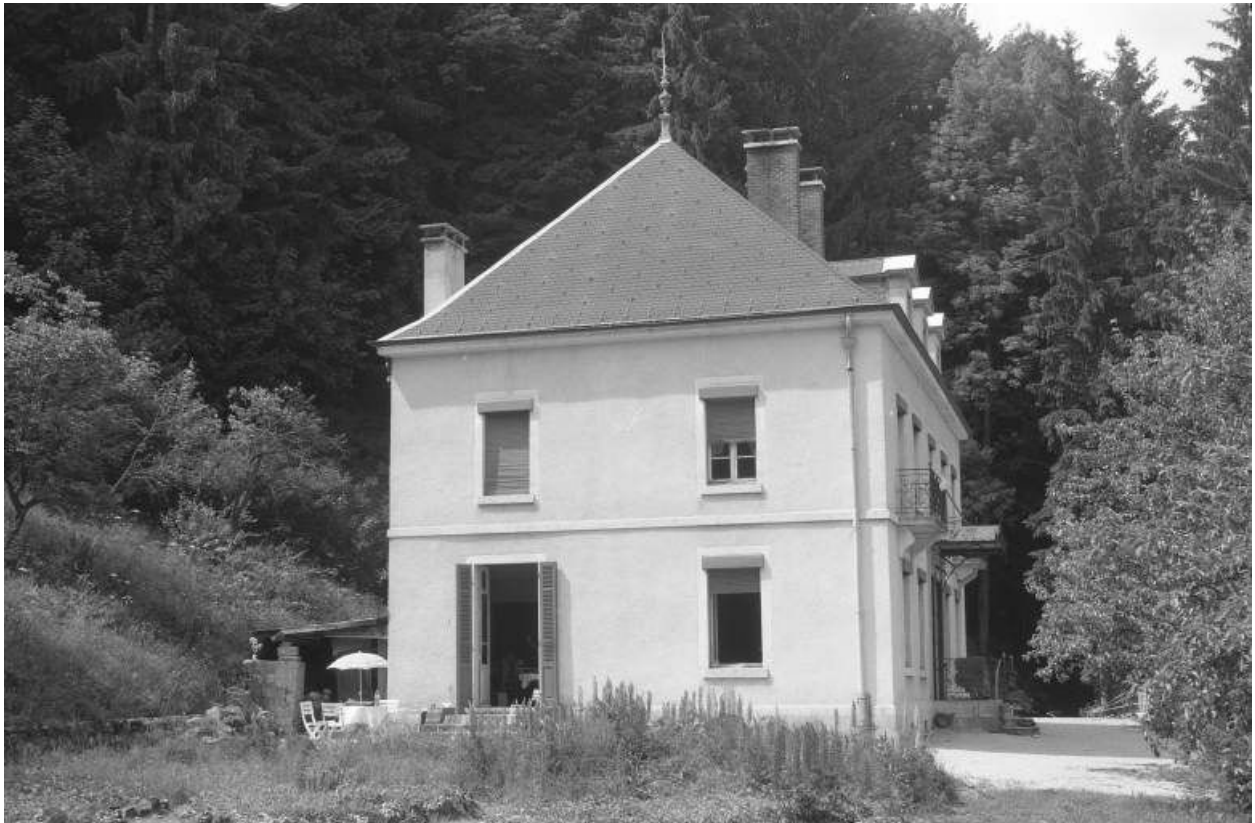
Façade latérale gauche du logement patronal.
