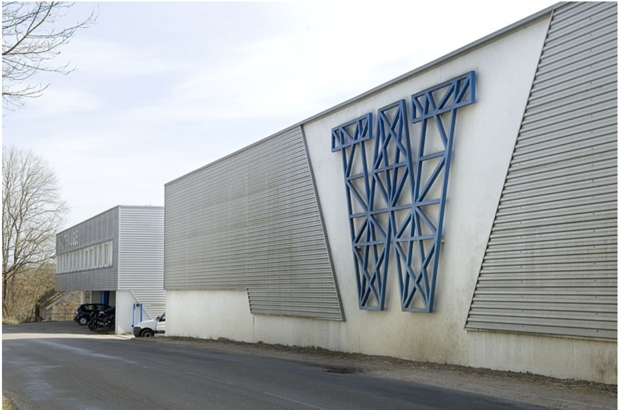
Bâtiments situés route de Champlitte. Façade nord.
