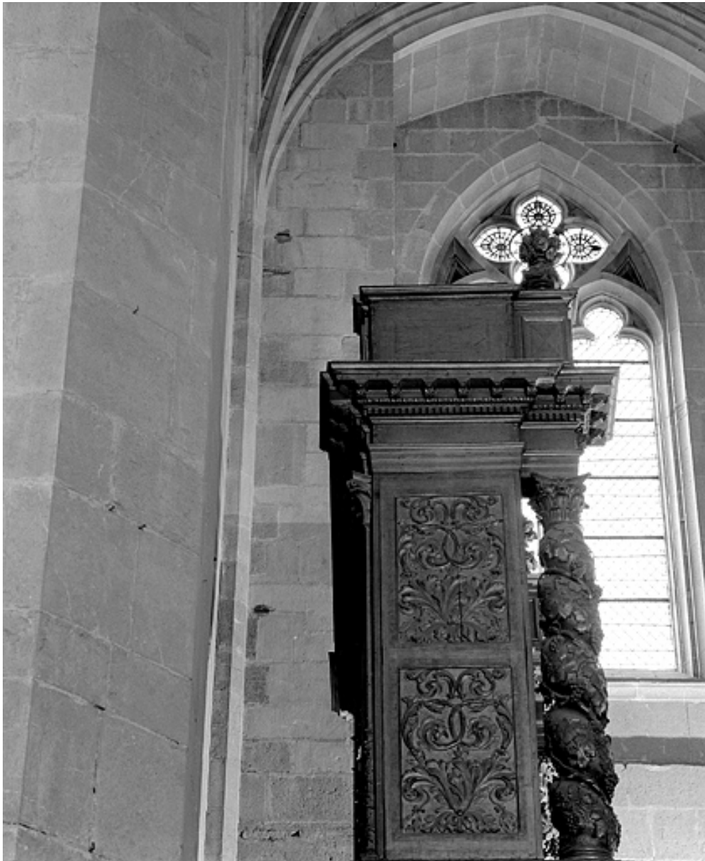
Détail du parement du collatéral sud à hauteur de la huitième travée.
