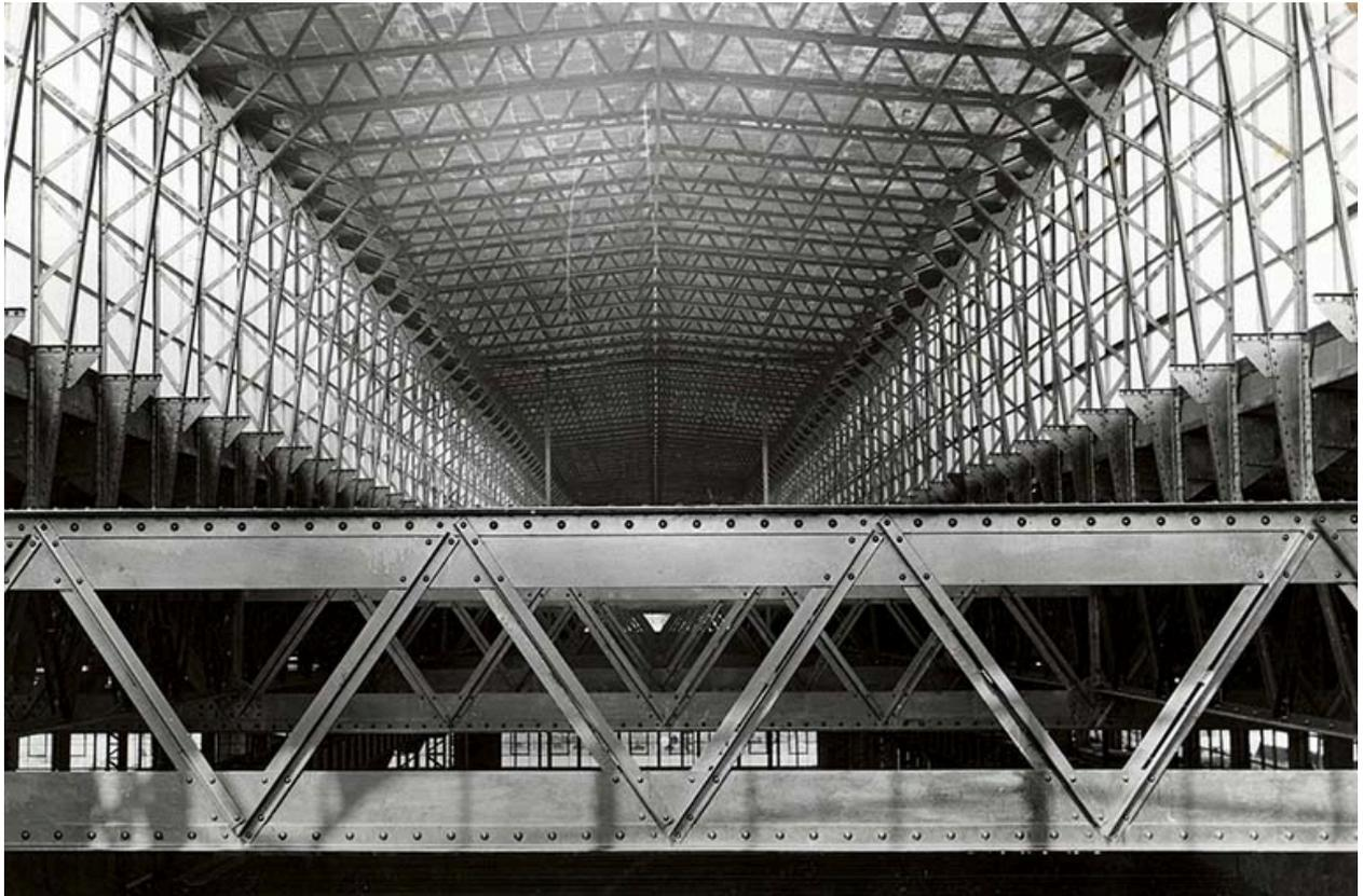
Ossature et charpente métalliques d'un atelier en construction.
