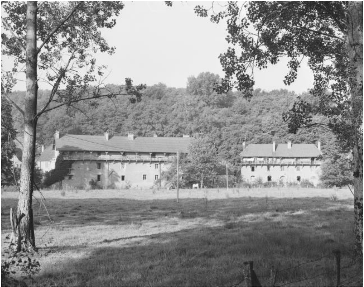
Façades postérieures des logements ouvriers.
