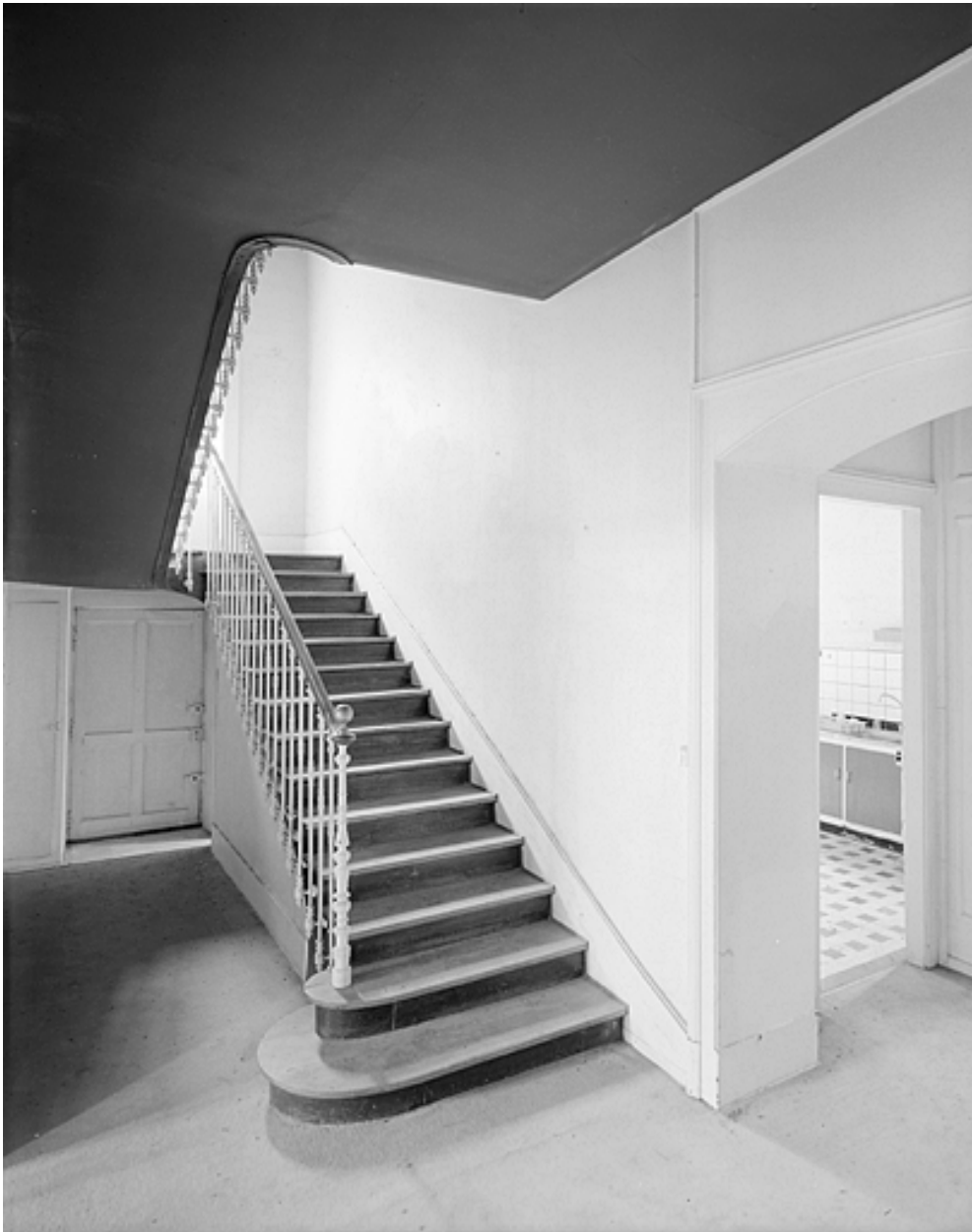
Partie sud : maison du directeur, escalier.
